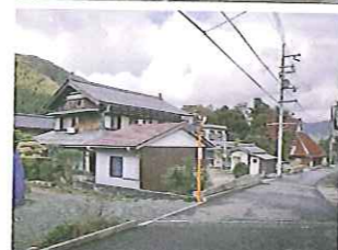
築120年の偉容を誇る納屋(上)。この地区には古くからの農家が多い(下)。
